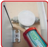
Priključci u vlažnim sredinama
